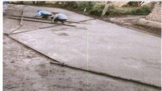
Foto 4: Reparación de planchas de concreto de patio ( T.O. 10 CM.)
